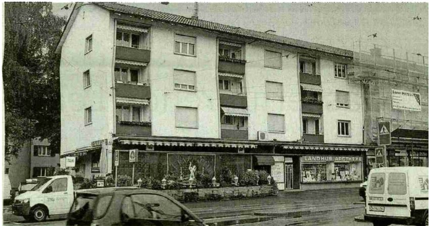
Mehrfamilienhaus an der Schaffhauserstrasse in Zürich vor dem Eingriff.
