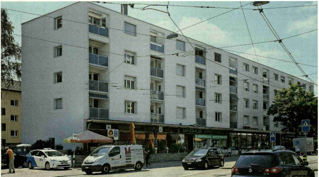
Aufstockung und Sanierung an der Schaffhauserstrasse in Zürich (Bauherrschaft: privat; Generalunternehmer: Häring Holz- und Systembau AG, Eiken). BILD HÄRING, EIKEN
