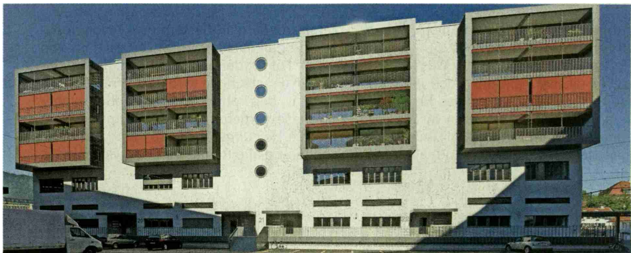
Viergeschossige Aufstockung SZU-Gebäude in Zürich (Bauherrschaft: Sihltal-Zürich-Uetliberg-Bahn SZU AG, Zürich; Architektur: Burkhalter Sumi Architekten, Zürich; Holzbauingenieur: Makiol Wiederkehr AG, Beinwil am See).
